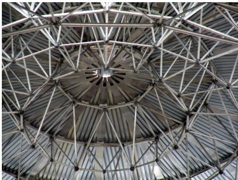
Figura 0-7.7: il sistema reticolare spaziale delle cupole geodetiche dell'impianto Enel di Torrevaldaliga Nord (Civitavecchia).
