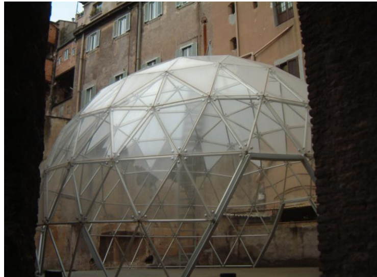
Figura 0-7.5: a) il particolare del collegamento asta-nodo tipo Geo-system; b) la copola geodetica all’interno del Museo dei Mercati Traianei.
