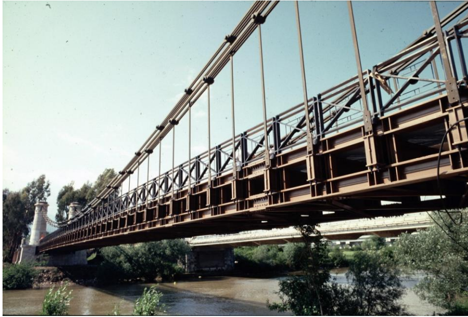
Figura 0-7.3: Il ponte “Real Ferdinando” sul Garigliano con luce di 80 m.
