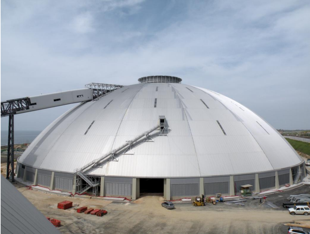
Figura 0-7.8: una delle due cupole geodetiche con diametro di 144 m dell'impianto Enel di Torrevaldaliga Nord (Civitavecchia).
