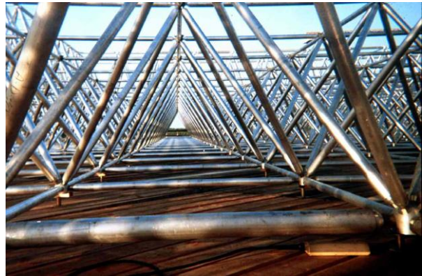
Figura 0-7.4: dettagli della copertura del Centro Congressi di Alghero.
